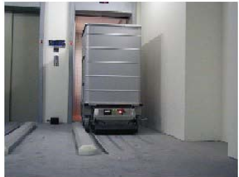
Sortie d'ascenseur sur glissière
