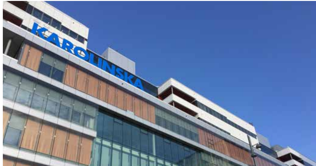
La façade du nouvel hôpital universitaire Karolinska Solna.
